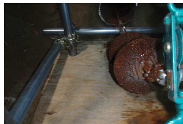
3. 事前施工:管内ブラシ清掃状況(完了)
