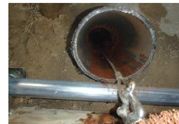
4. 事前施工:管内ブラシ清掃完了後の管内状況
