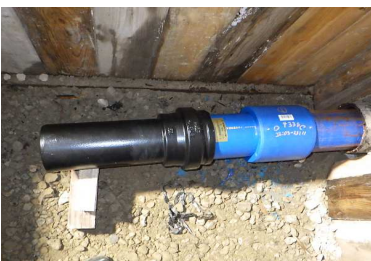
9. 本施工:到達坑側異種管継手接合(EF融着)
