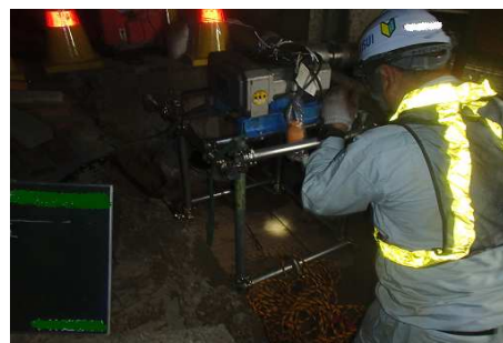
2.ウインチ引き込み状況(到達坑)
