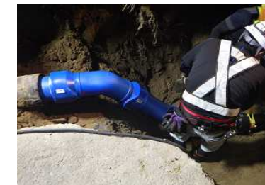
8. 本施工:発進坑側立下げ配管接続状況(EF融着)
