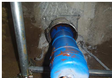
5. 事前施工:試験管通線状況
