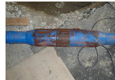
6. 事前施工:通線後の試験管状況
