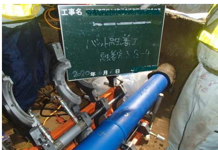
1.バット融着状況(発進坑)
