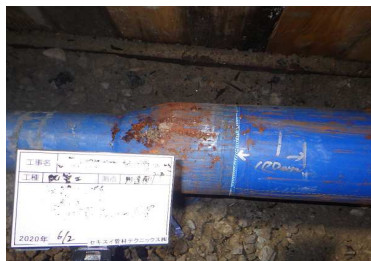
7. 本施工:PIP完了状況
