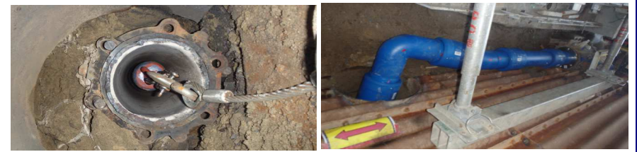
7.引込状況(先端部)
