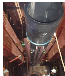
5.管材吊降ろし状況
