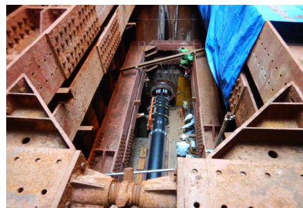
2.発進立坑内部
