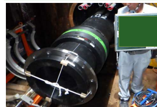
9.両端フランジ付き短管接続
