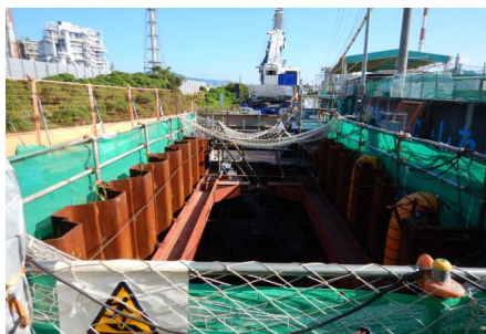
1.現場状況(発進立坑)
