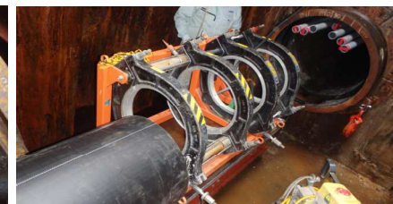
4.融着機設置状況2
