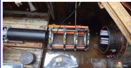
3.融着機器設置状況1
