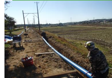
5. 人力での10m管敷設
