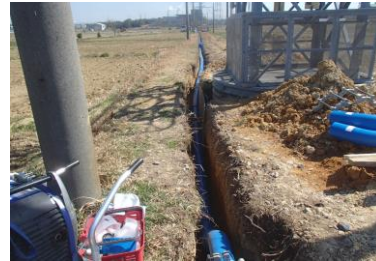
7. 生曲げ敷設後状況
