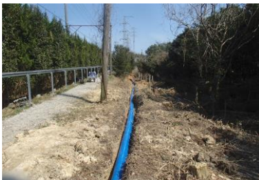
9. 生曲げ敷設後状況
