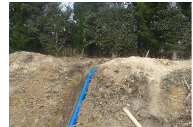
8. 法面配管敷設
