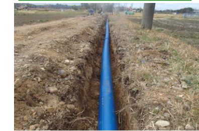
6. PE管敷設後状況
