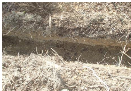
2. 掘削状況(幅300mm深さ300mm)
