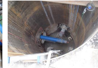
6. PE管引込完了
