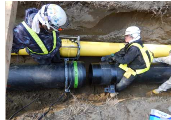
5.大口径PE管施工状況①
