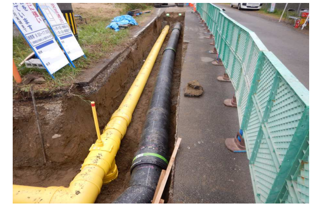
8.ガスPE管水取器施工状況
