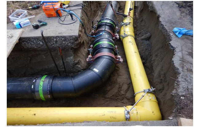
6.一般道路施工状況①
