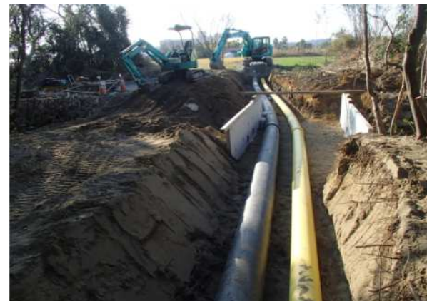
9.最小曲げ半径(R=34m)の生曲げ状況
