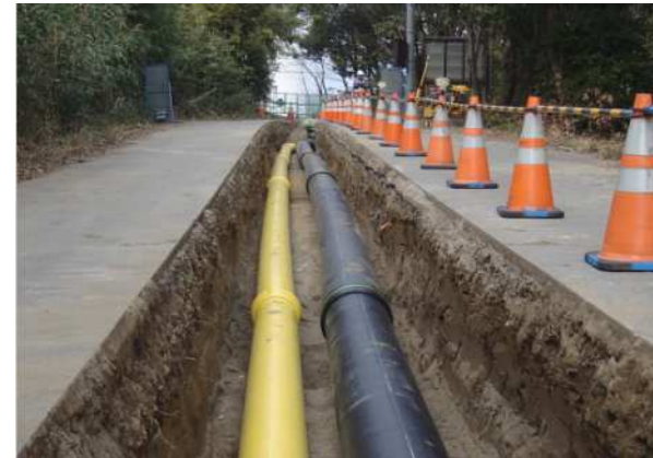
7.一般道施工状況②
