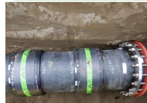
11.フランジ短管接合
