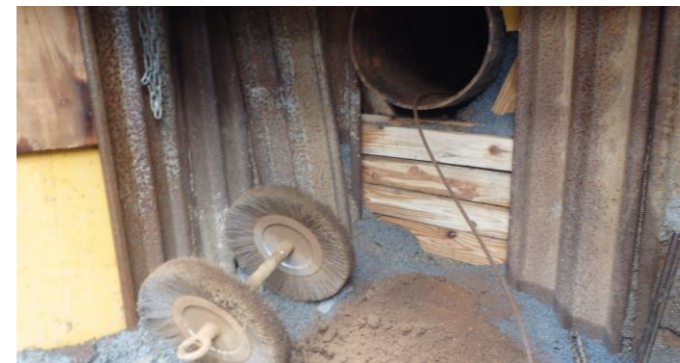
5.既設管内簡易清掃
