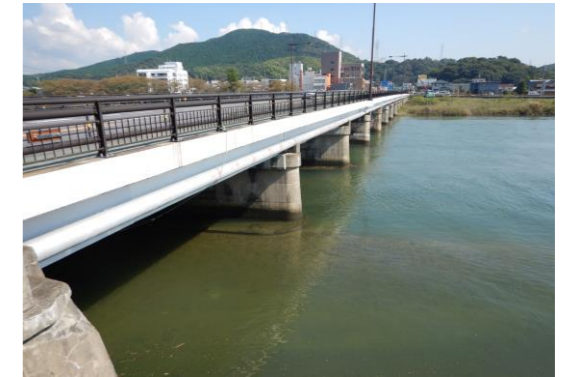
4.施工既設管全景
