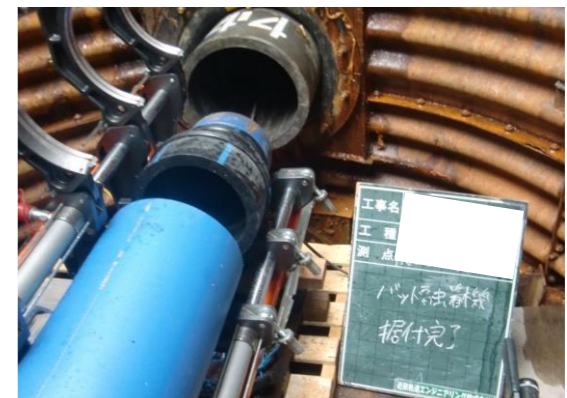
6. パイプイン引込準備状況
