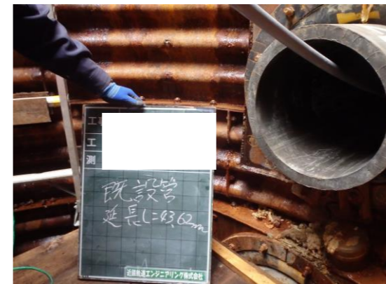
3. 既設管状況(レジン推進管)
