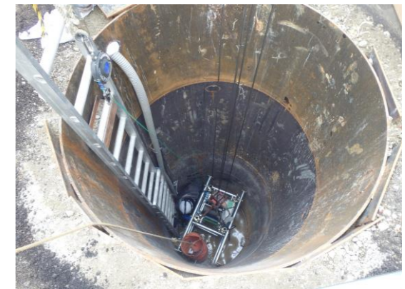
4. 到達側引込ウインチ設置状況
