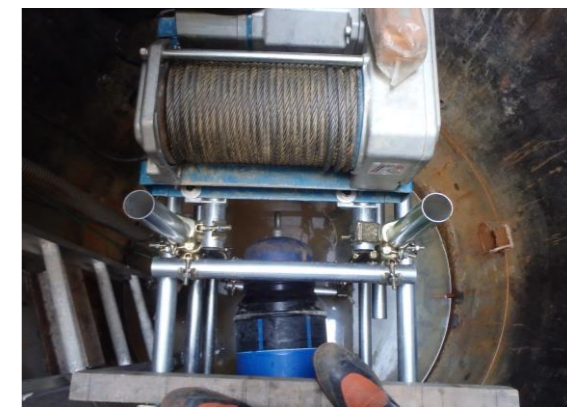
8. 先導管到達側立坑へ引込完了
