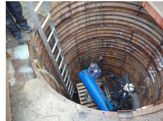
7. 立坑内パイプ荷下ろし(L=1250)
