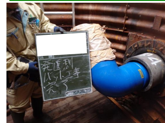
9. 発進側バット工事、引込完了
