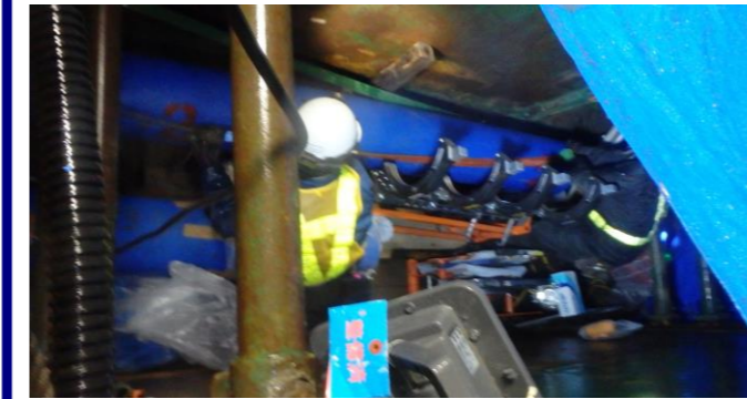
7.雨天時施工状況
