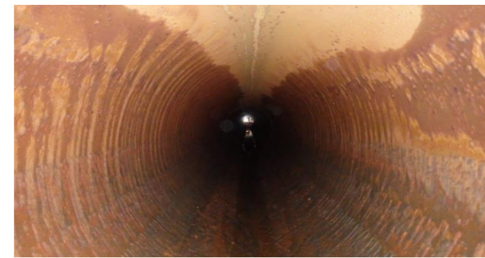
4.鞘管内状況(鋼管)
