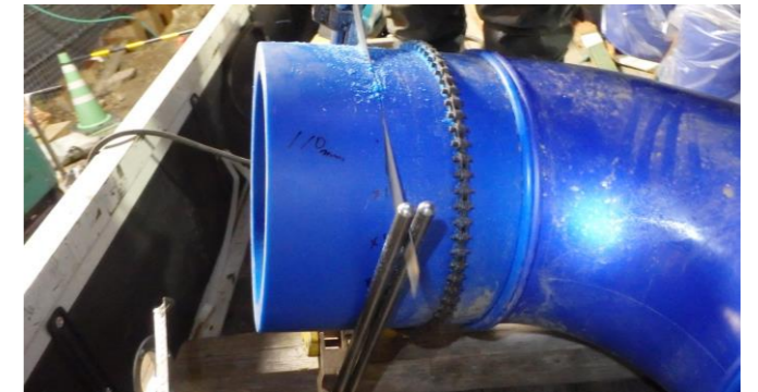
8.人孔内配管(90° ベンド)切断調整
