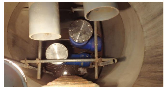
10.人孔内配管施工完了
