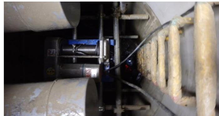
2.到達立坑(4号人孔内)及びウインチ設置状況
