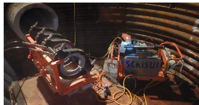
4.発進側融着機設置状況
