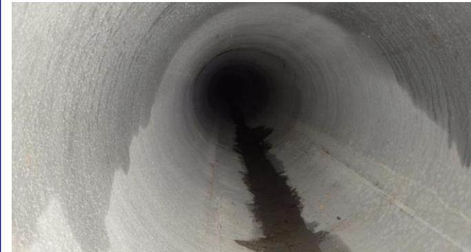
7.鞘管内状況(HPφ450新管)
