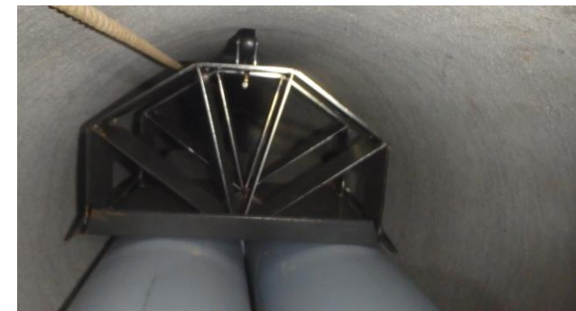
9.浮上防止治具設置
