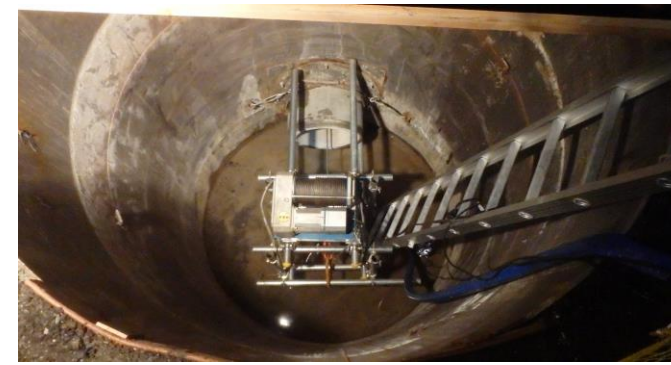
5.到達側立坑内
